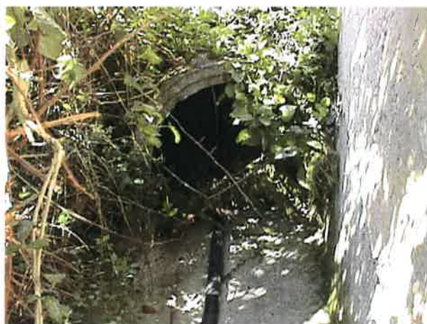
Ouvrage n°7 : Accès villas Ovoïde 0,90m x 1,40m (fond bétonné \rightarrow h = 0,80m )
