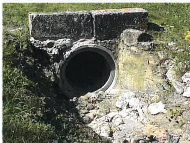
Ouvrage n°4 : Abri bus Buse ø600
