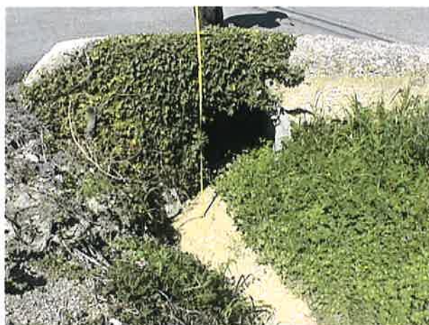
Ouvrage n°8 : Accès chemin amont station d'épuration Ovoïde 0,90m x 1,40m (fond ensablé \rightarrow h = 1m )
