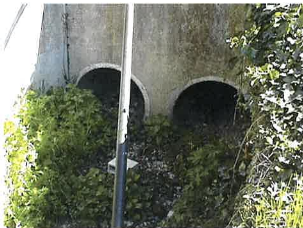
Ouvrage n°8 : Accès chemin amont station d'épuration Ovoïde 0,90m x 1,40m (fond ensablé \rightarrow h = 1m )
