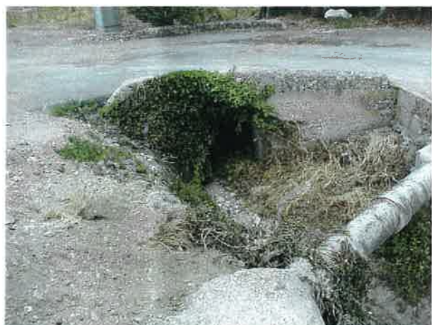
Ouvrage n°9 : Accès station d'épuration Ovoïde 0,90m x 1,40m
