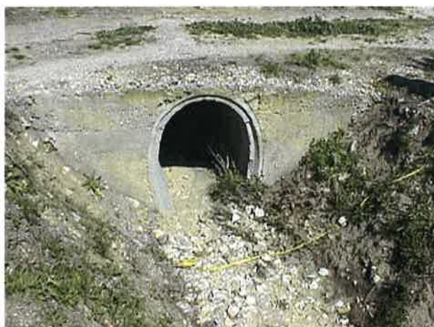
Ouvrage n°10 : Accès chemin aval station d'épuration Ovoïde 0,90m x 1,40m
