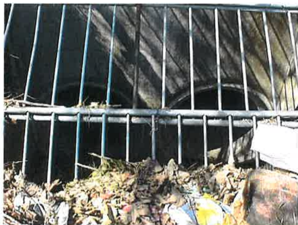
Ouvrage n°7 : Accès villas Ovoïde 0,90m x 1,40m (fond bétonné \rightarrow h = 0,80m )
