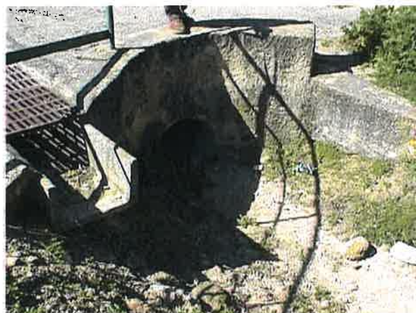
Ouvrage n°2 : Ecole Buse ø600
