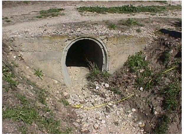
**Figure N° 21. VABRE DE ST-SAUVEUR - EXEMPLE D'UN OVOÏDE ENGRAVE**
