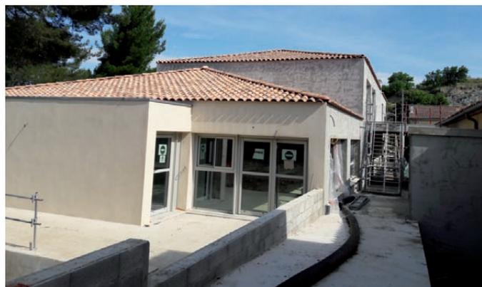
Le bâtiment est maintenant hors d'eau et hors d'air (Gros œuvre, couverture et menuiseries extérieures posées) et nous continuons les lots secondaires à l'intérieur du bâtiment.
