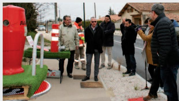
Le principe est simple : la bouche incendie est enterrée et signalée par une balise plastique de couleur rouge avec des bandes rétro réfléchissantes, qui présente l'avantage d'être souple et flexible.
