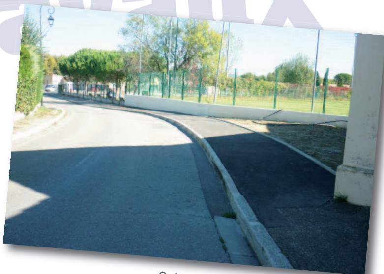
Création trottoir : rue du 8 mai 1945
