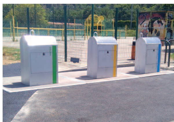
PAV Enterrés : rue du 8 mai 1945
