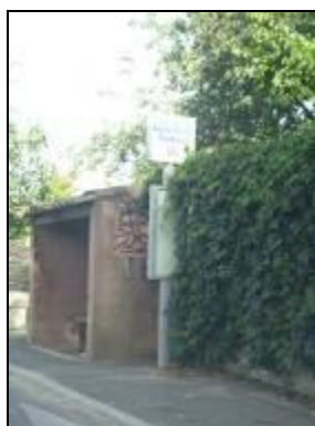
Desserte au niveau du lavoir
