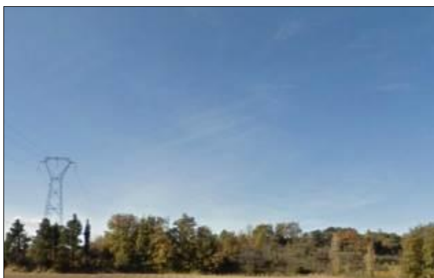
Secteur Nph depuis la RD 16
