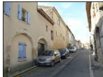
Zone UA : Maison de ville en R+1/2
