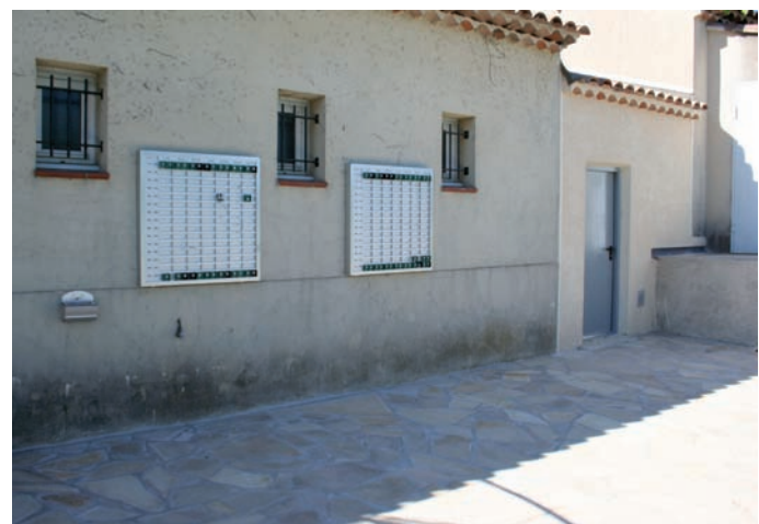
Construction d'un local rangement pour le Tennis Club d'Alleins, prolongement de la terrasse.
