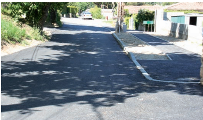
Vallon de Gipan : aménagement de la voirie, aménagement de l'évacuation des eaux pluviales et sécurisation du cheminement piétons.
