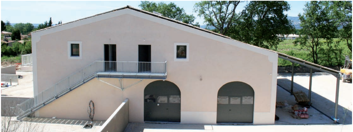
Poursuite des travaux au CTM
